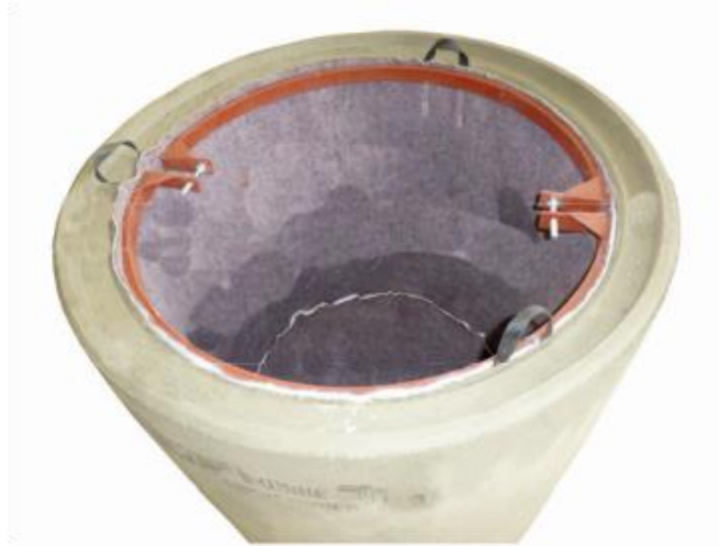
Eingebauter Filtersack im Schacht DN 1000
