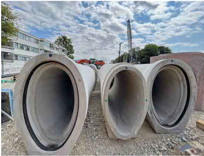
Stahlbetonrohre ÜE 600/1100.
