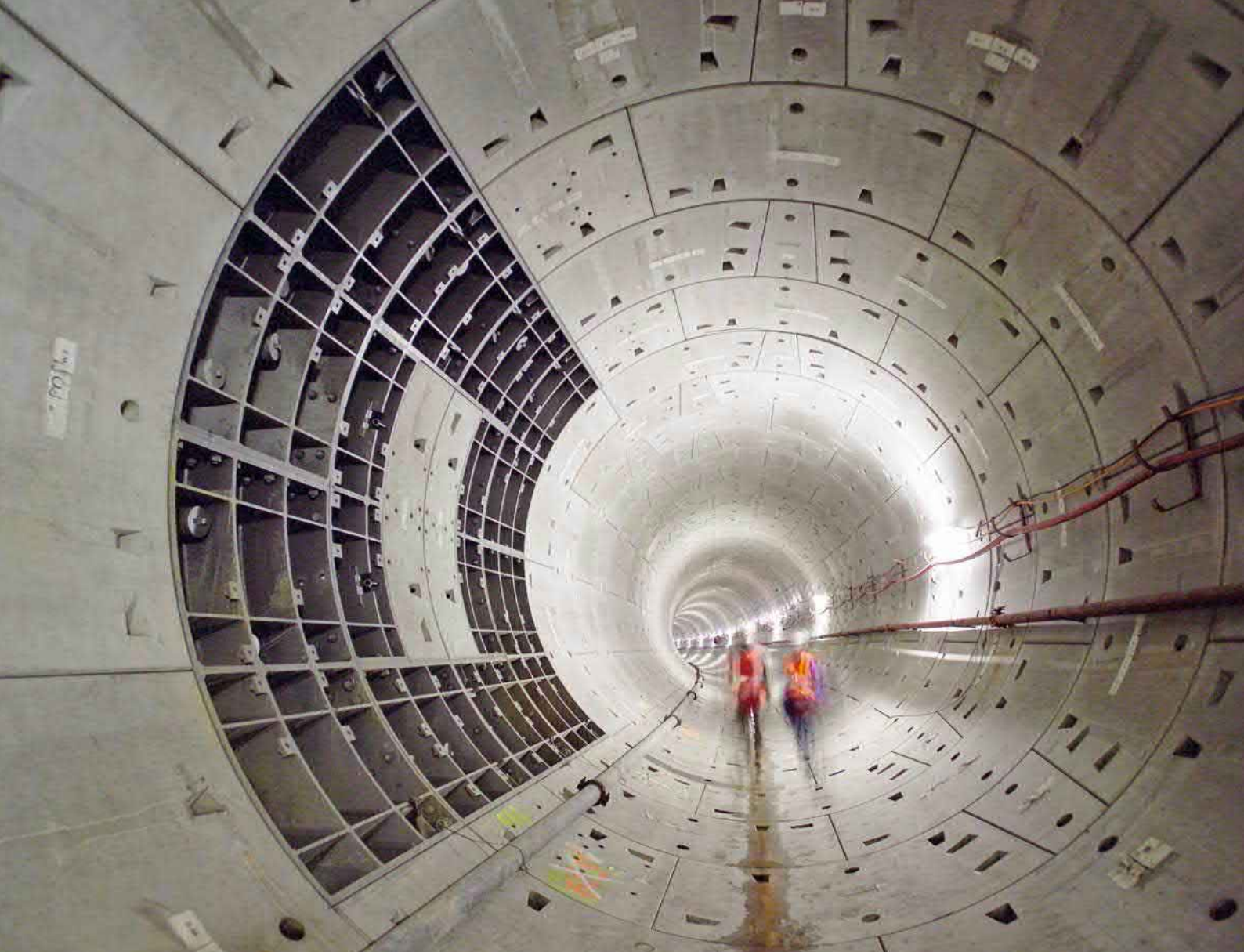
Tunnelröhre aus Tübbingen.
