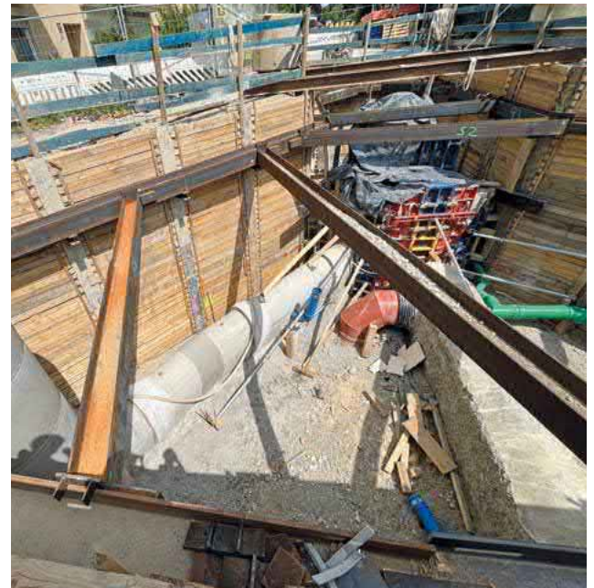
Einblicke in eine Baugrube: Neuer Kanal (links), Bestandskanal (rechts) und Provisorien (Kunststoffrohre).
