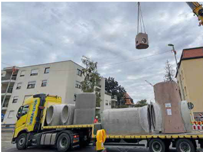
Anlieferung von Schächten und Rohren.
