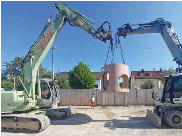
Stahlbeton-Fertigteilschacht mit Hochleistungsbeton.
